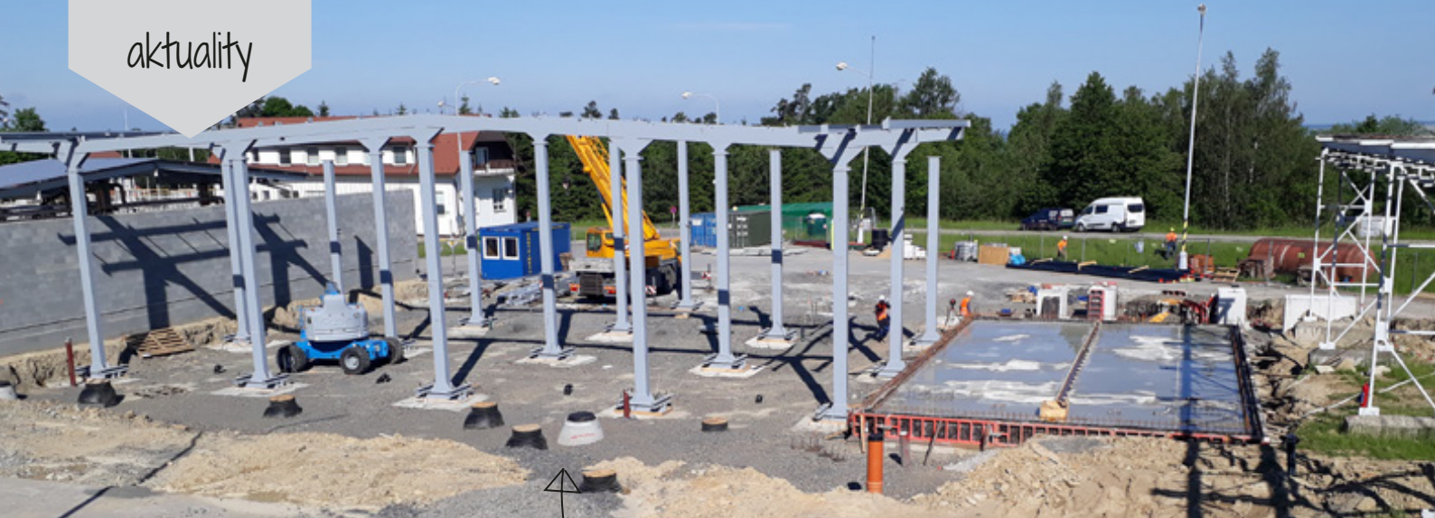
výstavba výdejních lávek
